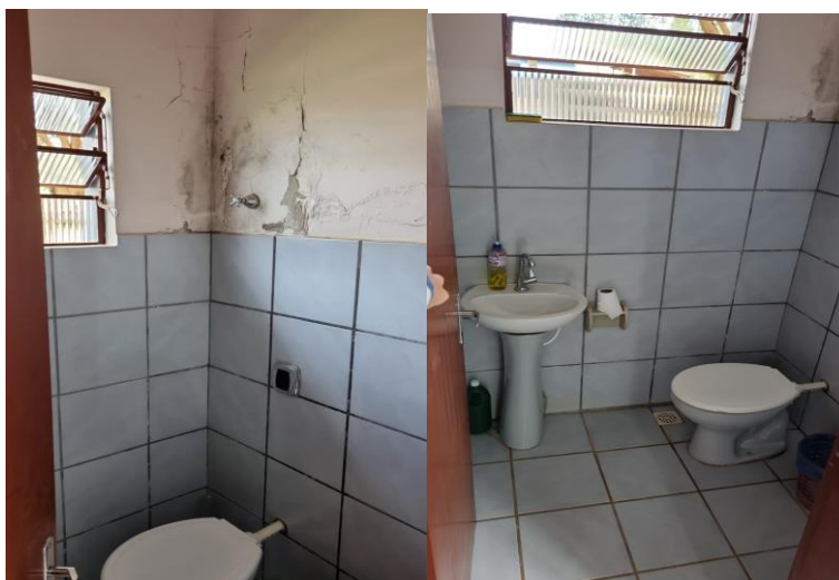
Imagens da parte interna do sanitário que será adaptado
