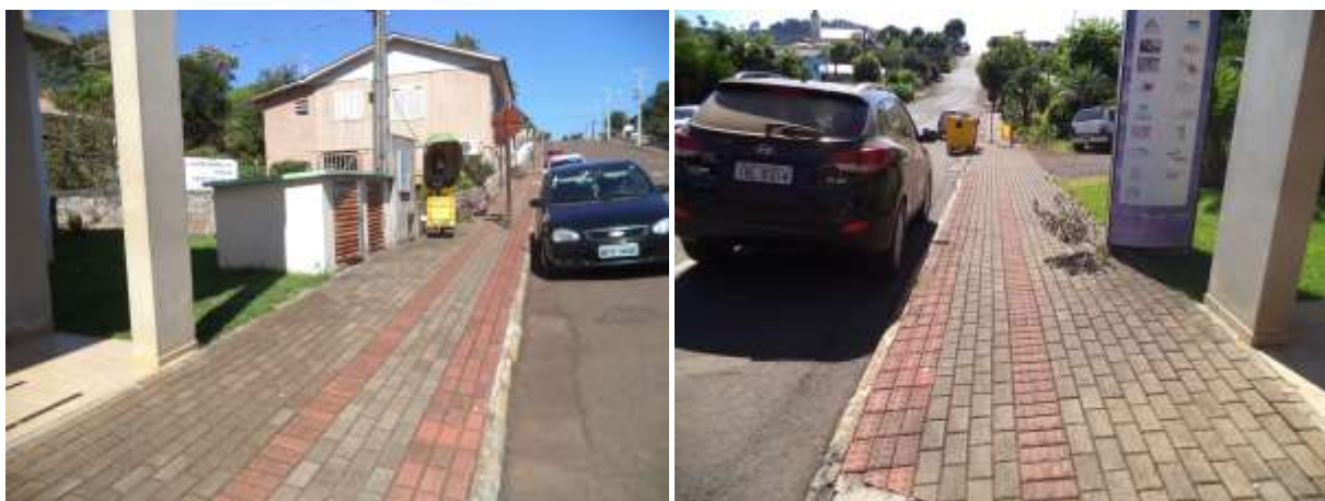
Vistas do paver existente a remover
