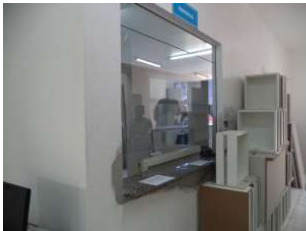
Guichê existente da farmácia a ser adequado.
