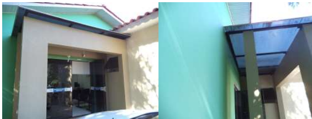
Cobertura do acesso à sala de reuniões
